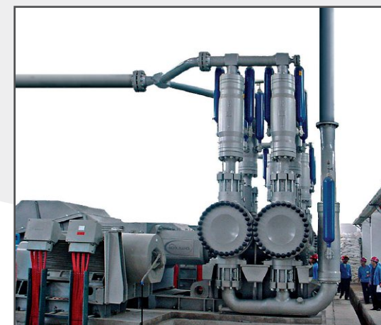
Самый большой шлангово-мембранный поршневый насос FELUWA. Производительность: 260 м³/ч под давлением нагнетания 100 атм.
